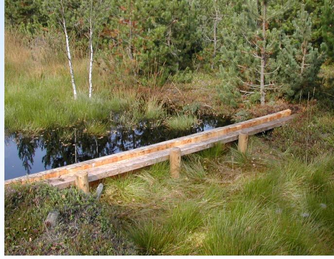
Holz als Dicht-/Baumaterial nicht dauerhaft genug (Wechselwasser, Biber)!
