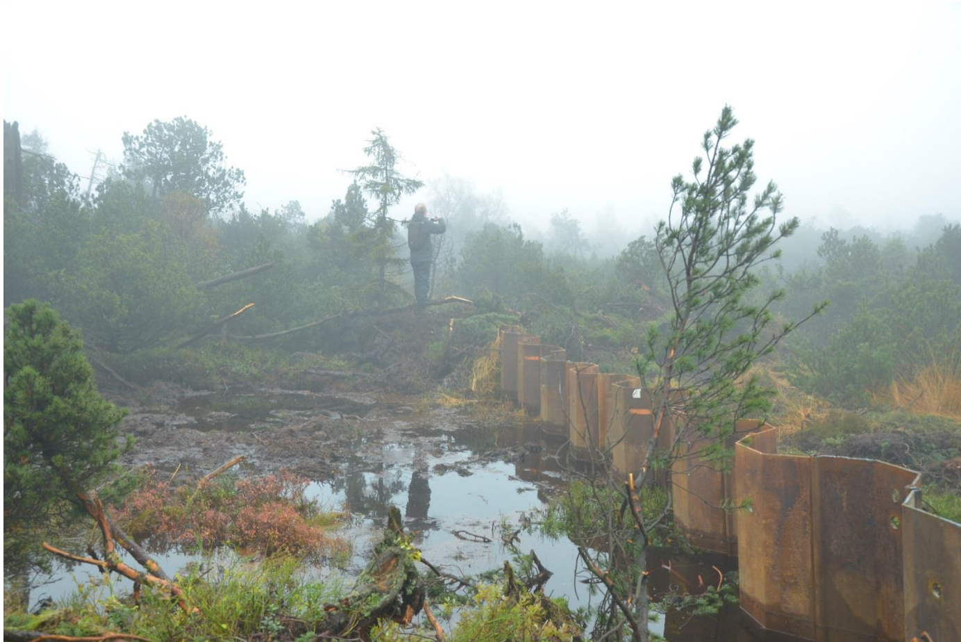
Dammbauwerk aus Metallspunddielen
