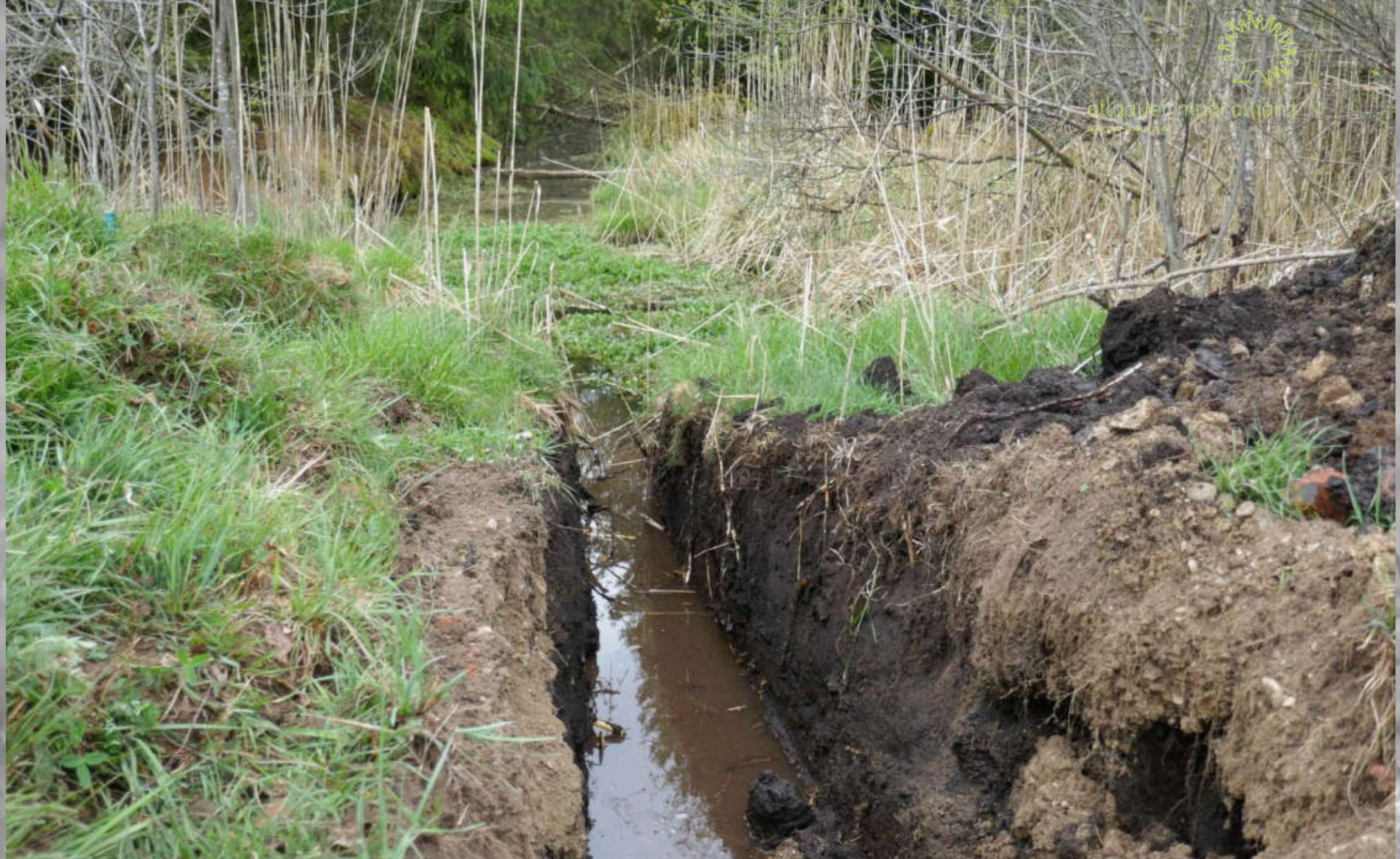
Sammler – Durchstich durch Randgehänge-Torso und Einlauf in Torfstich
