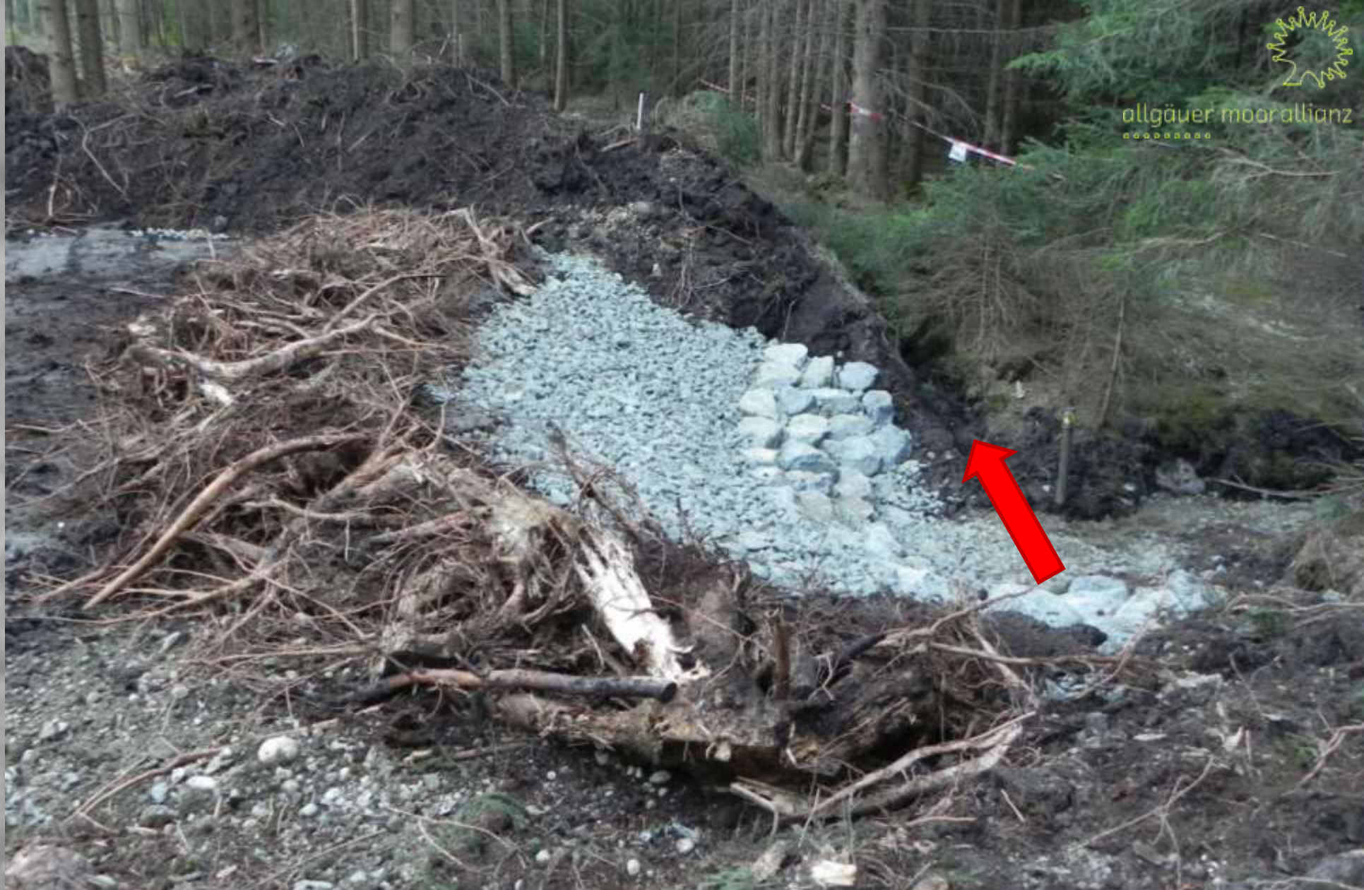
Hauptgraben Räsenmoos – Sicherung/Überleitung an Grundstücksgrenze (Grenzgraben)
