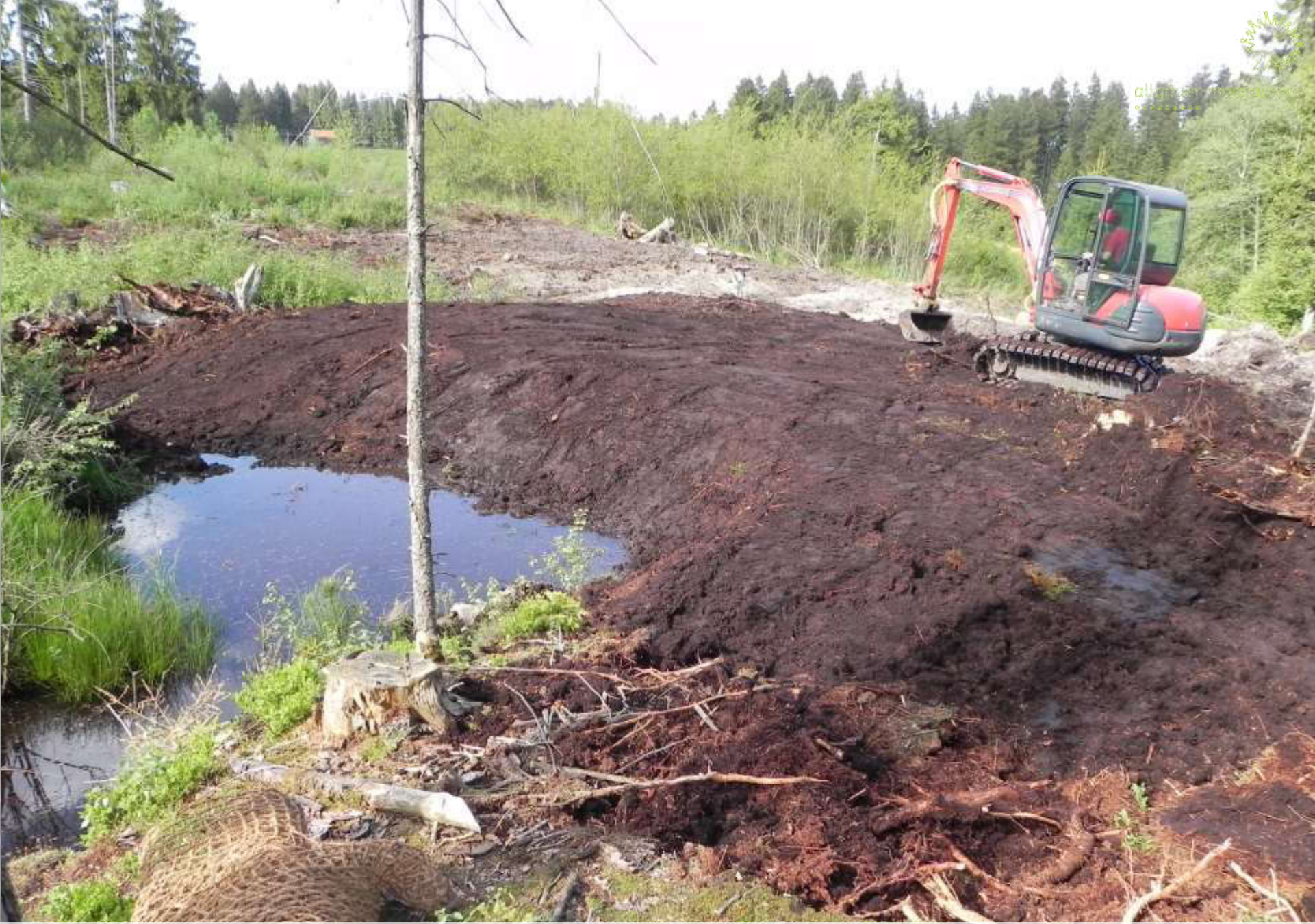
Anschließend Abdeckung mit Torf; Umleitung Abfluss in ursprüngliche Abzugsrinne
