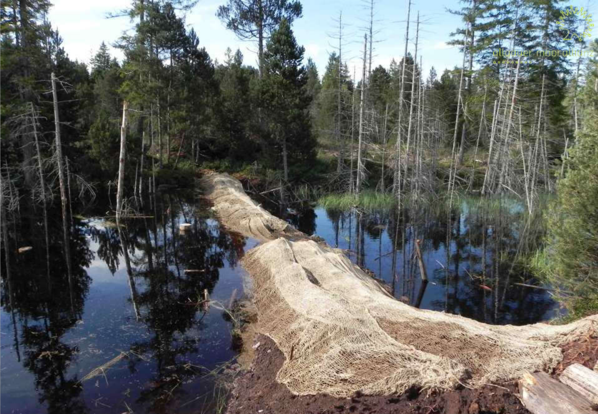
Großer West-Ost-Torfstich: Technische Dämme mit Stahlspundung (Juli 2021)
