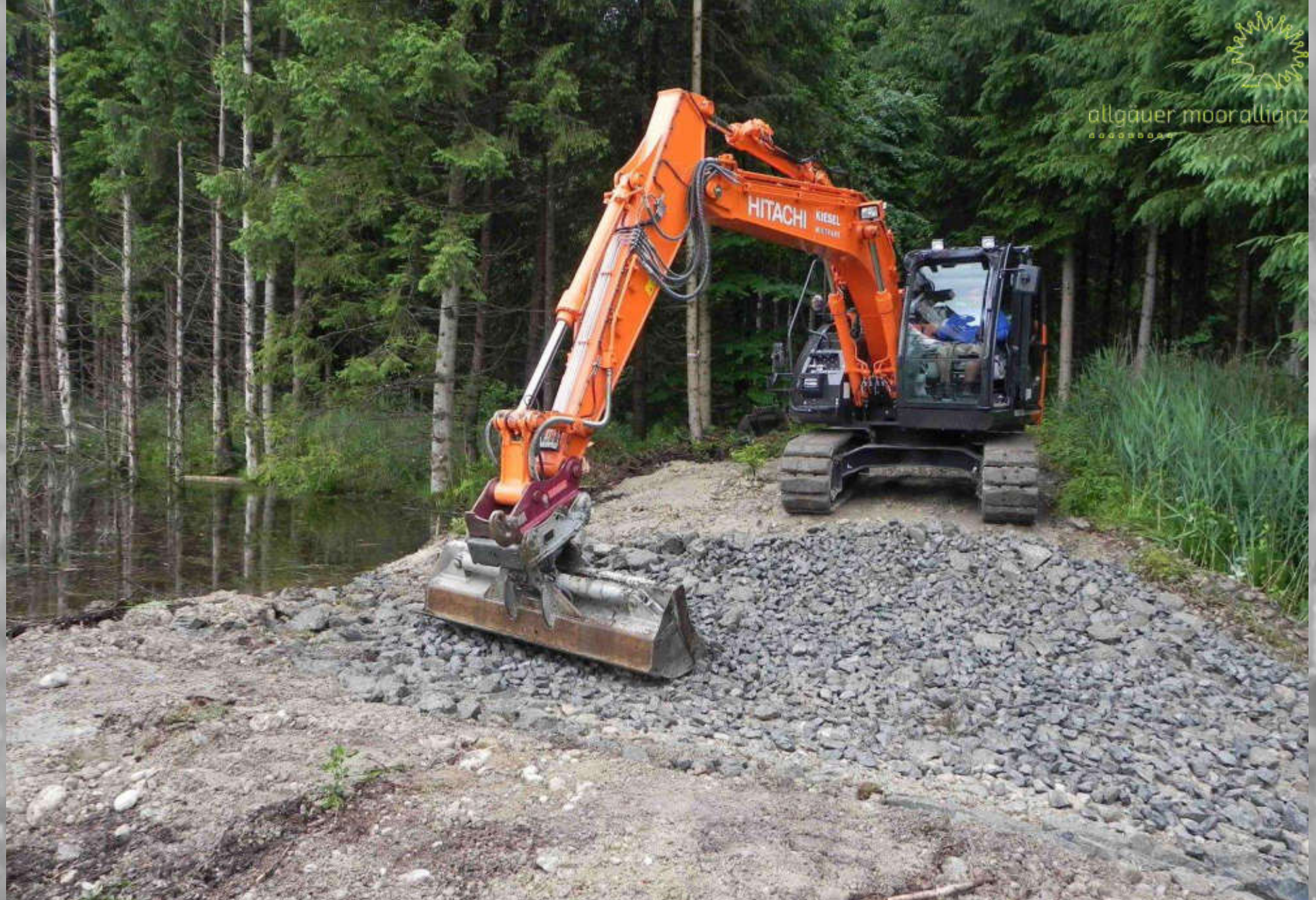
Schwindenmoos: Ertüchtigung und Korrektur Anstau Torfstichkanal West: Definierter Überlauf
