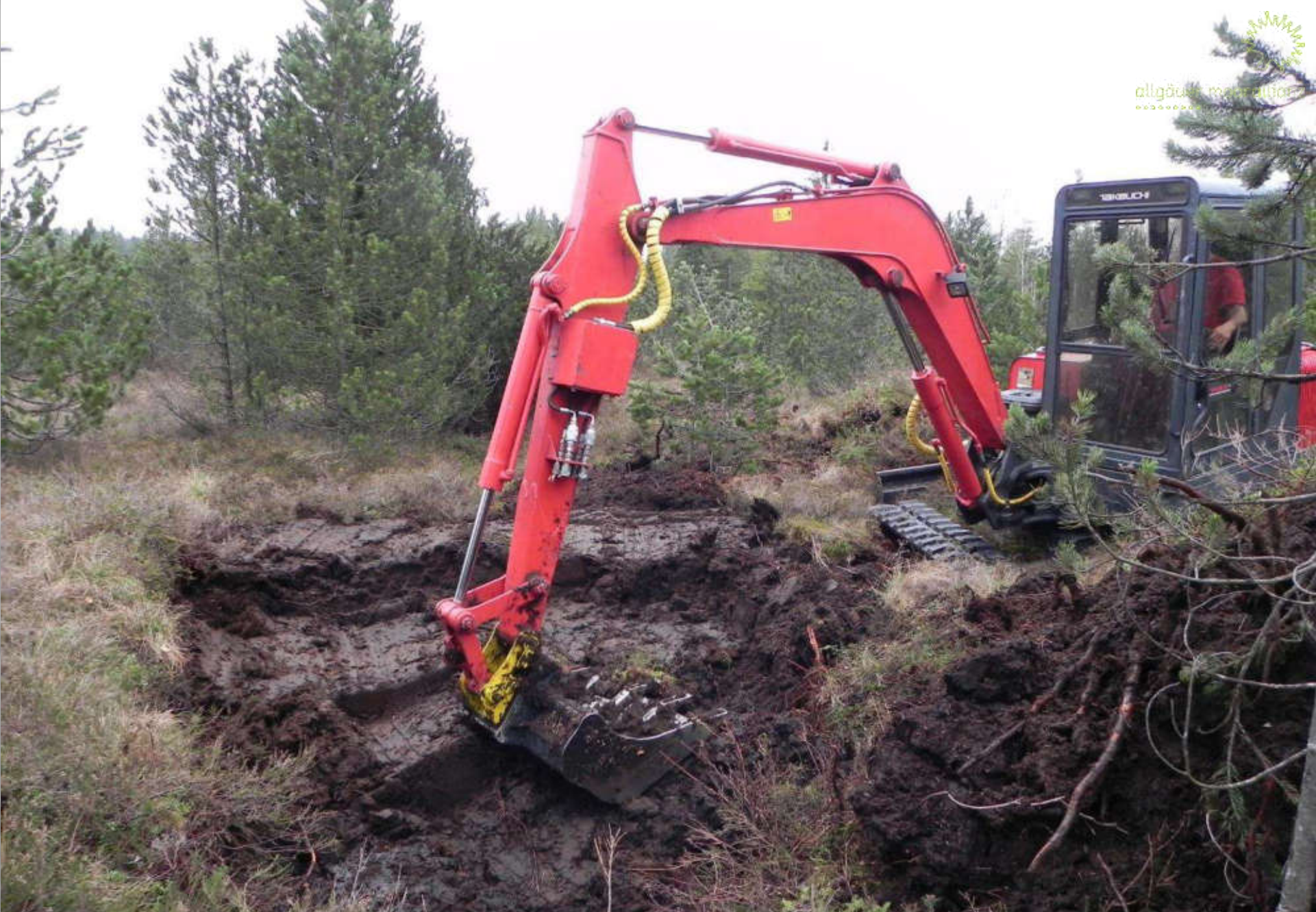
Seemoos – Anstau von Schlitzgräben mit sorgfältig modellierten Torfdämmen
