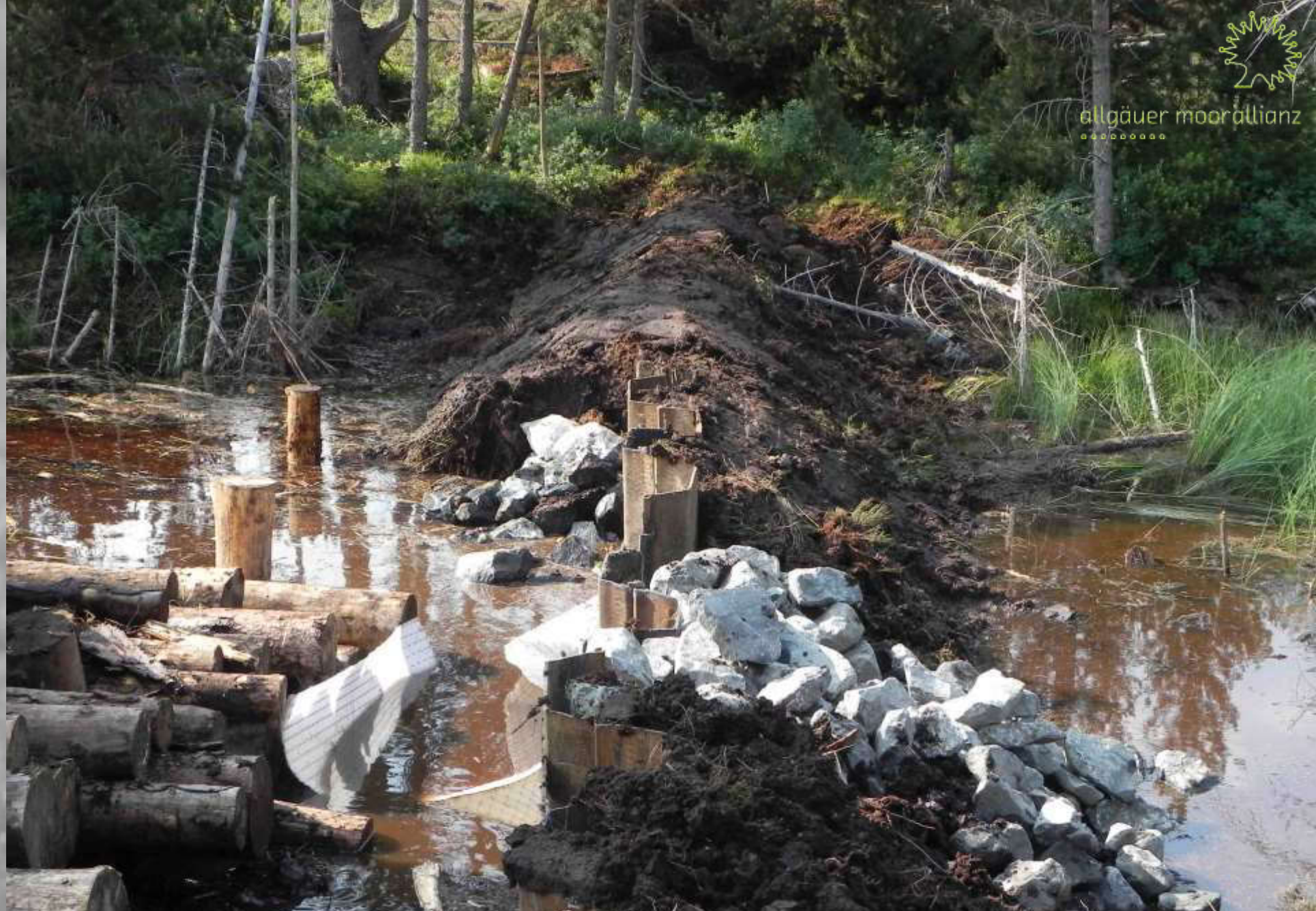
Großer West-Ost-Torfstich: Technische Dämme mit Stahlpundung (Juli 2021)
