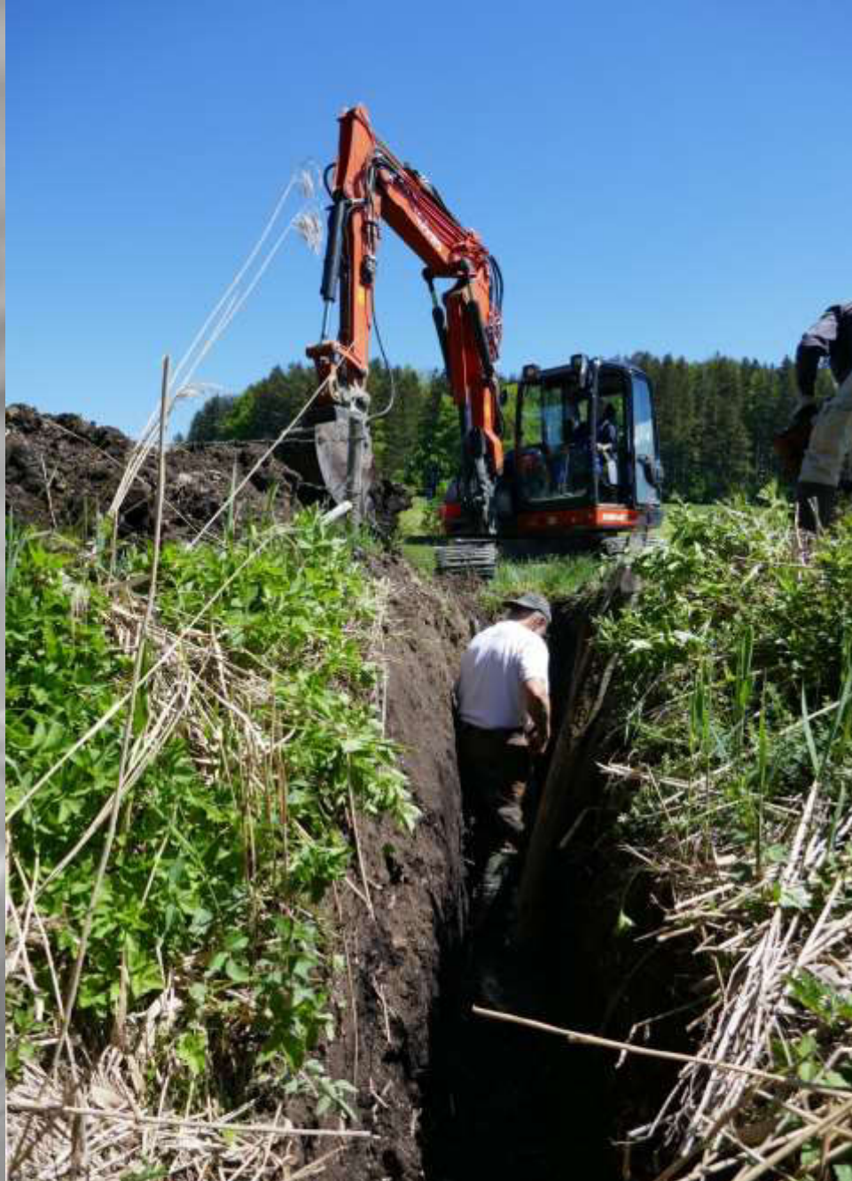
Tief liegende Drainage unter Weg/Überfahrt – Anhebung & Ersatz durch geschl. Rohr
