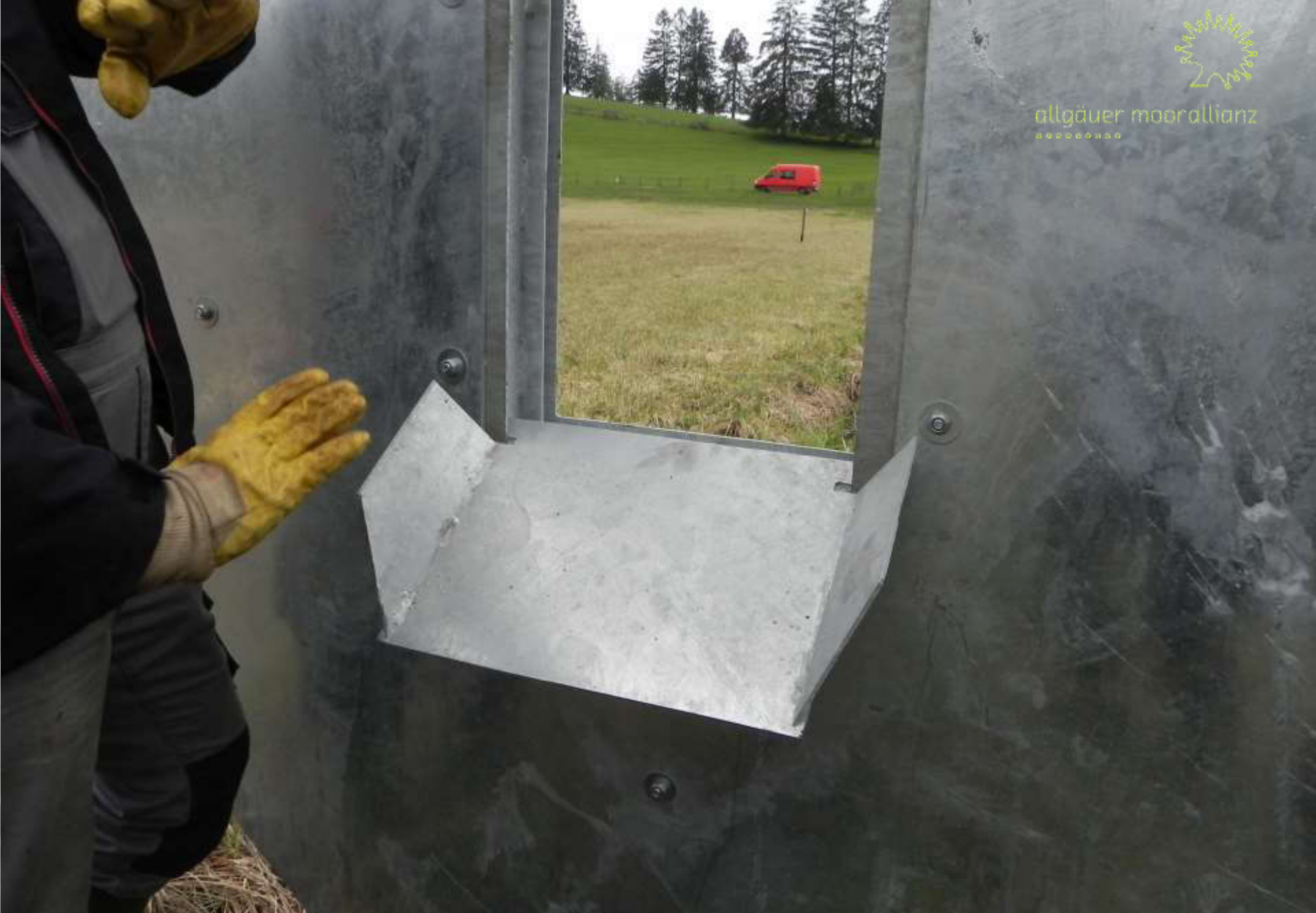
Streuwiese Reitzen: neues Wehr – Tosboden nach Einbau einzuhängen (2023)
