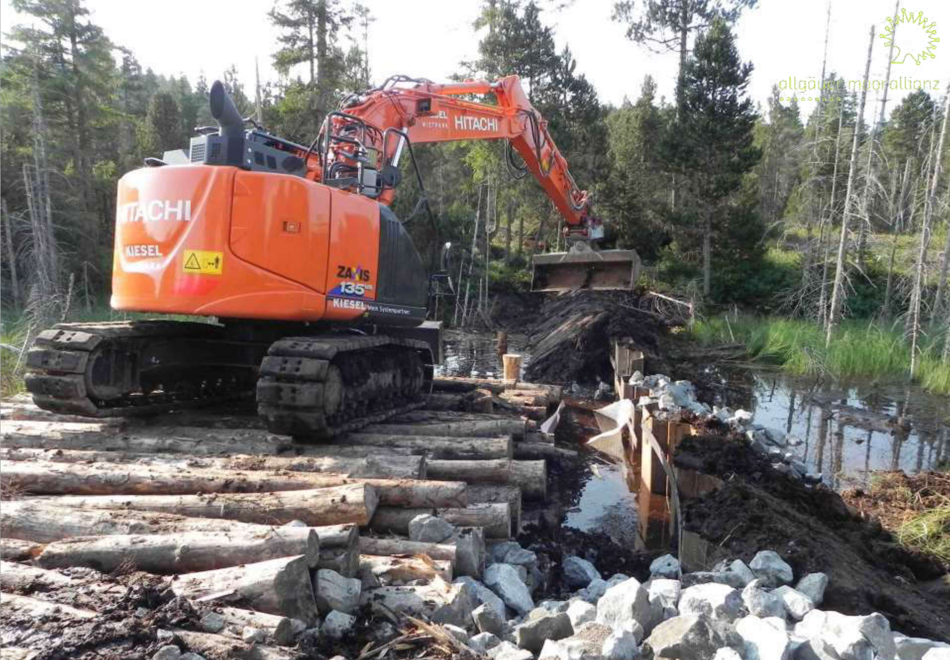
Großer West-Ost-Torfstich: Technische Dämme mit Stahlspundung (Juli 2021)
