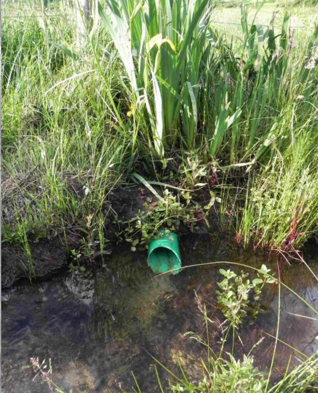
Drainagestrang vom Oberlieger – Durchleitung im geschl. Rohr bis zum Grenzgraben (61 m)
