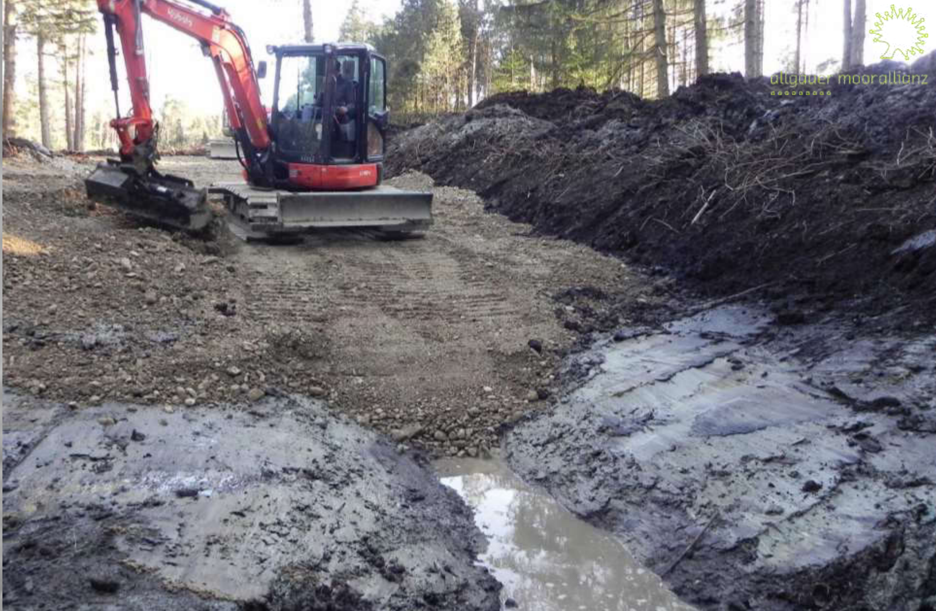
Hauptgraben Räsenmoos (Sohle in Grundmoräne) – Abschlussbauwerk am nördlichen Moorrand
